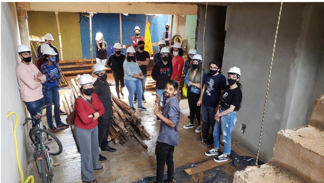
Figura 2. Visita a obra com estagiários do Escritório Escola
